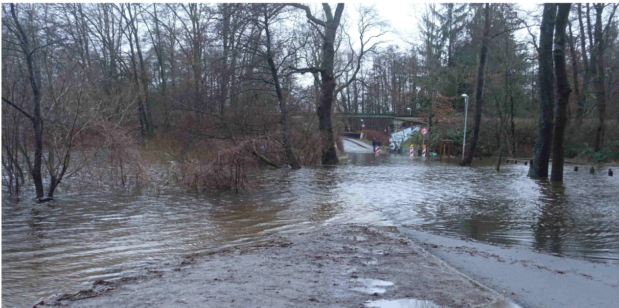
überfluteter Amselweg im Dezember 2023 (Foto: Uwe Wenk)
