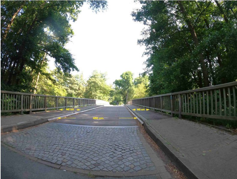
Bild Nr. 4: Amselbrücke mit Abmessungen (Foto: Uwe Wenk)
