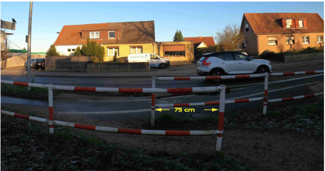
Umlaufsperrre Hamburger Straße - Überlappung der Sperrelemente (Foto: Uwe Wenk)
